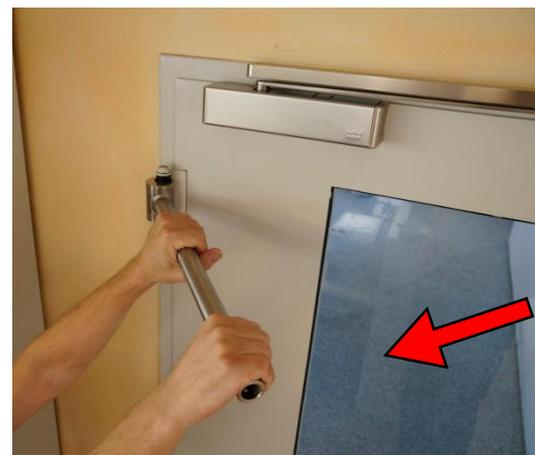
**Bild 4:** Bandoberteil nach außen biegen
