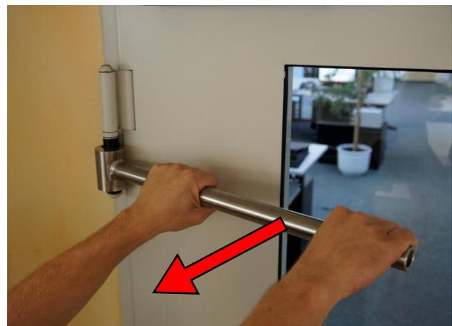
**Bild 2:** Bandunterteil nach außen biegen
