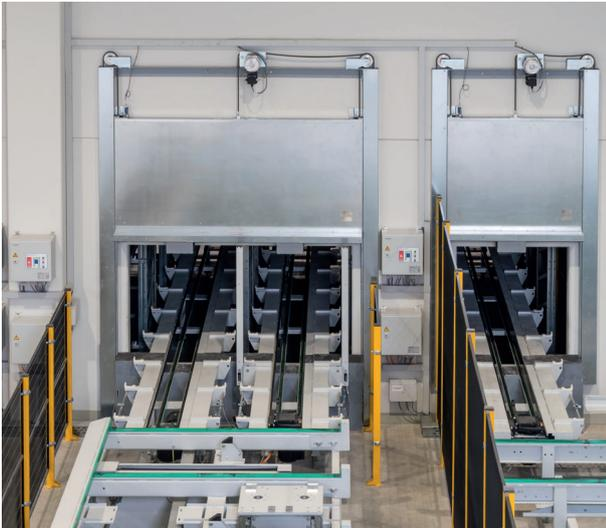
Führen Förderanlagen durch eine Brandwand, so sind speziell hierfür geprüfte und zugelassene „Feuerschutzabschlüsse im Zuge bahngebundener Förderanlagen“ (FAA) erforderlich.
