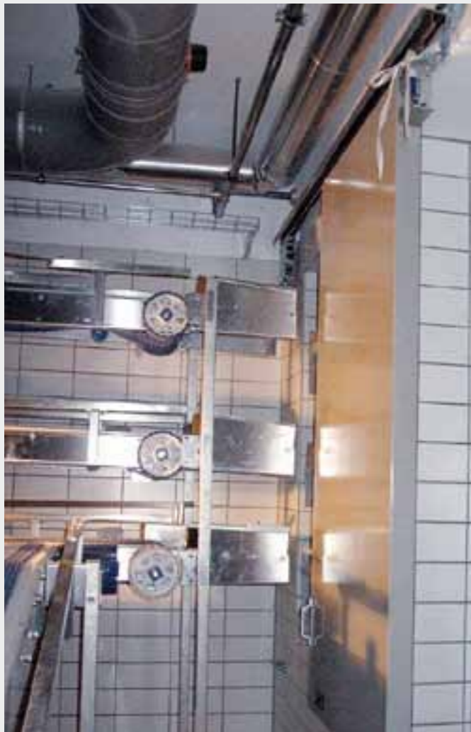
Förderanlagenabschlüsse Wünsche | Conveyor system closures Wünsche | Fermetures coupe-feu pour convoyeurs Wünsche | Cintas transportadoras Wünsche
