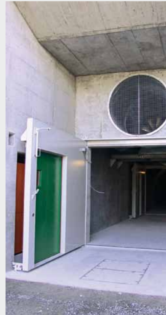
Umfahrung Giswil, Schweiz|Bypass tunnel Giswil, Switzerland| Tunnel de la Rocade de Giswil, Suisse|Circunvalación Giswil, Suiza
