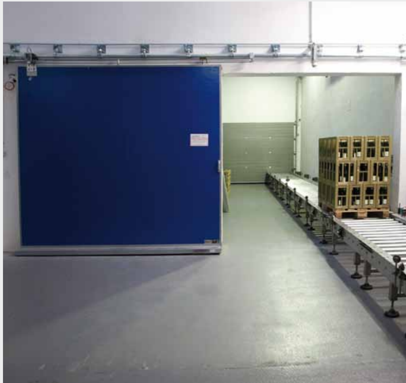
Förderanlagenabschlüsse Alde Gott, Sasbachwalden|Conveyor system closures Alde Gott, Sasbachwalden|Fermatures coupe-feu pour convoyeurs Alde Gott, Sasbachwalden|Cintas transportadoras Alde Gott, Sasbachwalden
