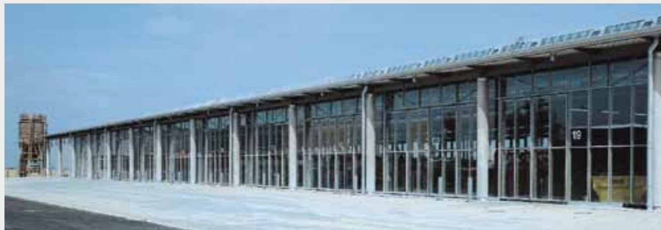
Feuerwache Flughafen Leipzig | Fire station Leipzig Airport | Caserne des pompiers Aéroport de Leipzig | Parque de bomberos aeropuerto Leipzig
