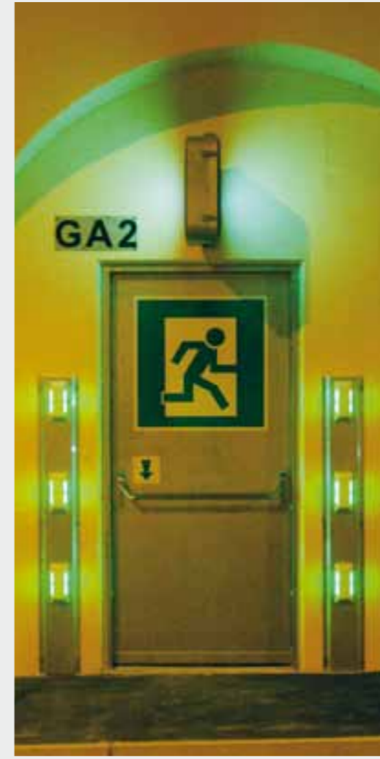
Citytunnel Waidhofen, Österreich/Citytunnel Waidhofen, Austria/Citytunnel Waidhofen, Autriche/Citytunnel Waid- hofen, Austria
