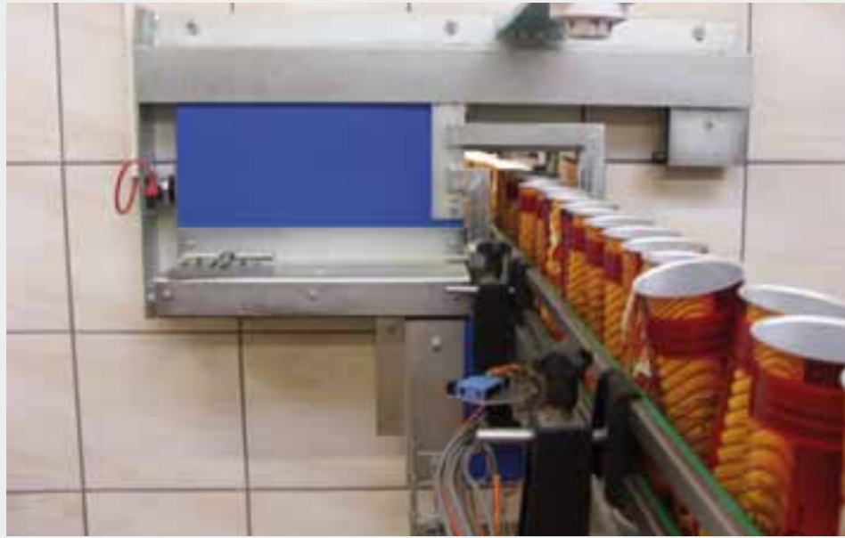
Förderanlagenabschlüsse Bahlsen GmbH | Conveyor system closures Bahlsen GmbH | Fermetures coupe-feu pour convoyeurs Bahlsen GmbH | Cintas transportadoras Bahlsen GmbH
