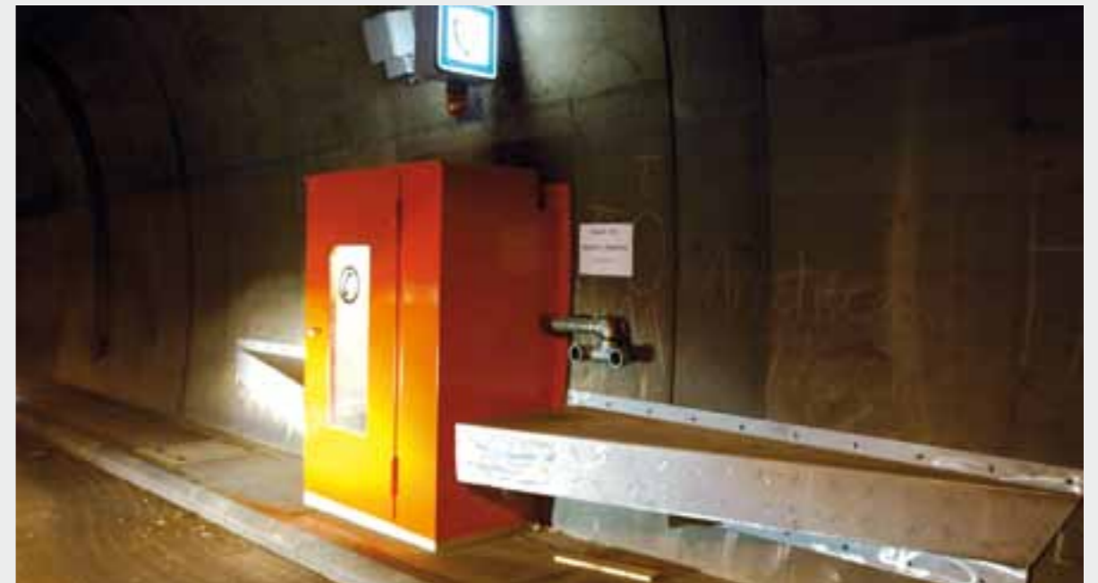
Saukopf Tunnel, Deutschland|Saukopf tunnel, Germany|Tunnel du Saukopf, Allemagne|Túnel de Saukopf, Alemania
