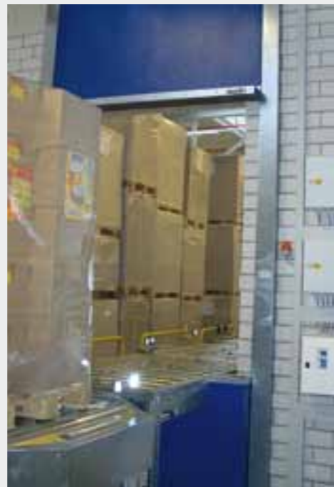
Förderanlagenabschlüsse Leopold | Conveyor system closures Leopold | Fermetures coupe-feu pour convoyeurs Leopold | Cintas transportadoras Leopold
