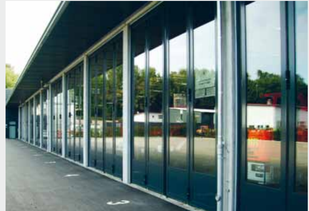
Feuerwache Kehl | Fire station Kehl | Caserne des pompiers Kehl | Parque de bomberos Kehl
