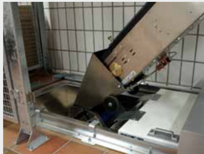
Förderanlagenabschlüsse Ritter-Sport GmbH & Co. KG | Conveyor system closures Ritter-Sport GmbH & Co. KG | Fermetures coupe-feu pour convoyeurs Ritter-Sport GmbH & Co. KG | Cintas transportadoras Ritter-Sport GmbH & Co. KG
