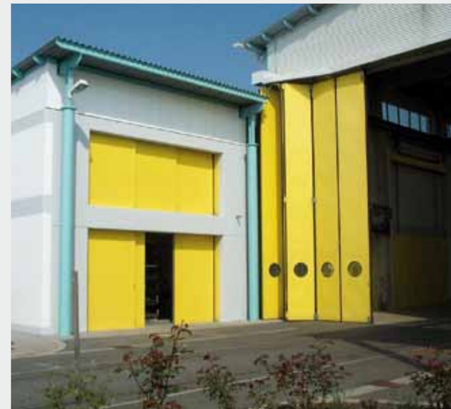
Staufufe Iffezheim | Iffezheim barrage | Le barrage d'Iffezheim | Embalse de Iffezheim
