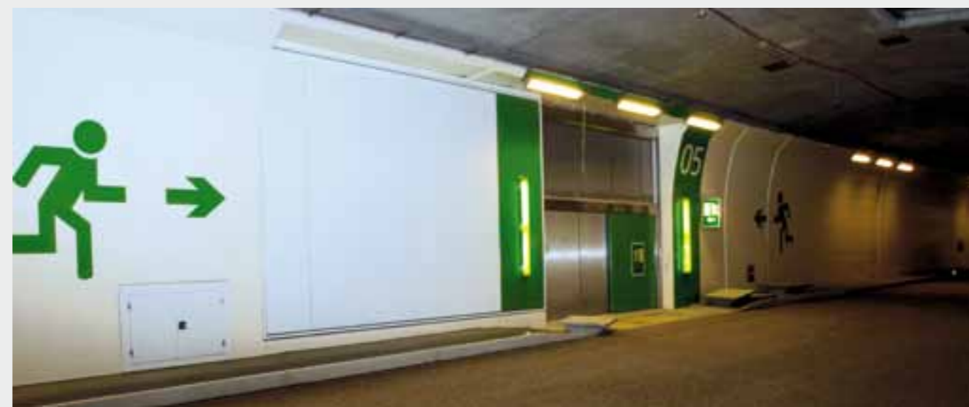
Kirchenwaldtunnel, Schweiz|Kirchenwald tunnel, Switzerland|Tunnel de Kirchenwald, Suisse|Túnel de Kirchenwald, Suiza
